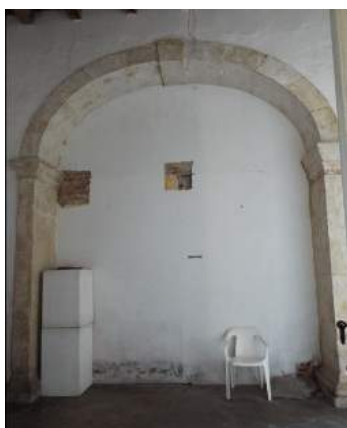
Figura 17. Detalhe do arco em cantaria, 2017
