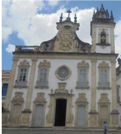
Figura 35. Fachada da Igreja de N. S.do Carmo
