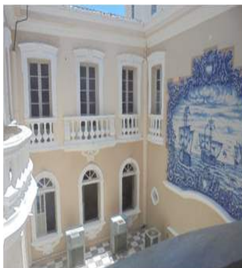
Figura 40 – Quadra claustral do antigo Colégio dos jesuítas, após modificações
