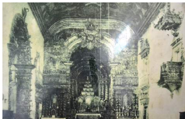
Figura 33. Interior da Igreja de Santo Antônio
