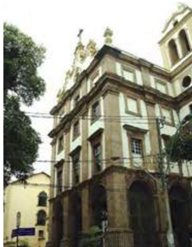
Figura 14. Mosteiro de São Bento, Salvador
