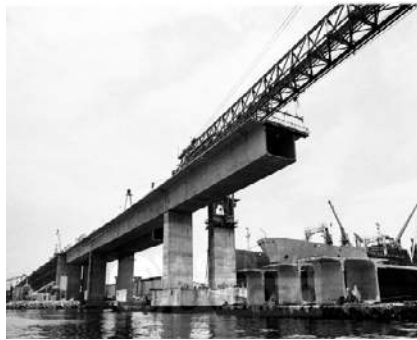
Figura 2. Viga de concreto da ponte Rio-Niterói com seção transversal de paredes finas
