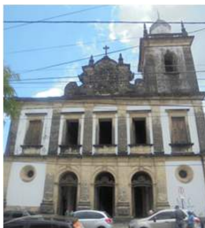
Figura 37. Fachada da Igreja de São Bento
