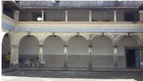
Figura 43 – Quadra claustal do antigo Convento dos franciscanos
